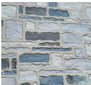
EASY-WALL ist ein vorgefertigtes Verblendersystem, bestehend aus einer Schicht Betonverblender, die in eine Platte aus Polyurethanschaum eingefasst sind (PUR).
